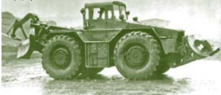
Фото 4. Инженерный колёсный тягач МАЗ-528 (ИКТ) с путеукладчиком ПКТ и бульдозером БКТ
